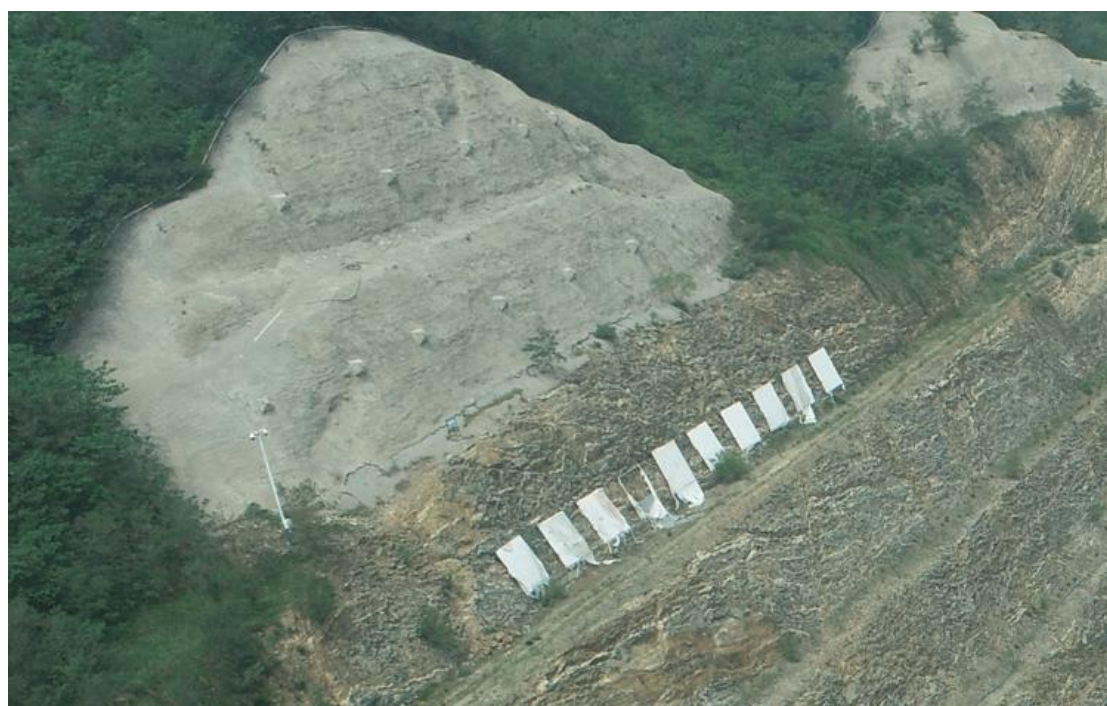
照片 0-1 I 采场西侧边坡支护情况
